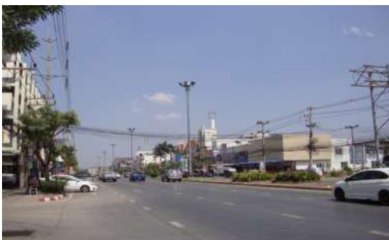
รูปที่ 1.2 เสาไฟฟ้าแบบเสาสูง ทางหลวงหมายเลข 224 ตอนควบคุม 0100 ตอน นครราชสีมา – หัวทะเล กม.0+425 – กม.0+665 (ปัจจุบัน)
