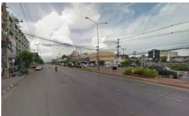
รูปที่ 1.1 เสาไฟฟ้าแบบกิ่งคู่ ทางหลวงหมายเลข 224 ตอนควบคุม 0100 ตอนนครราชสีมา – หัวทะเล กม.0+425 – กม.0+665 (เดิม)
