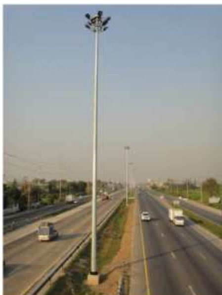
รูปที่ 2.3 แบบของเสาสูงที่ใช้งานบนทางหลวง (คู่มือแนะนำการติดตั้งอุปกรณ์กัน และสิ่งอำนวยความสะดวกความปลอดภัย, 2557)
